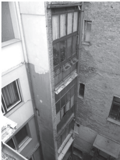
Dvorišna fasada, detalj
