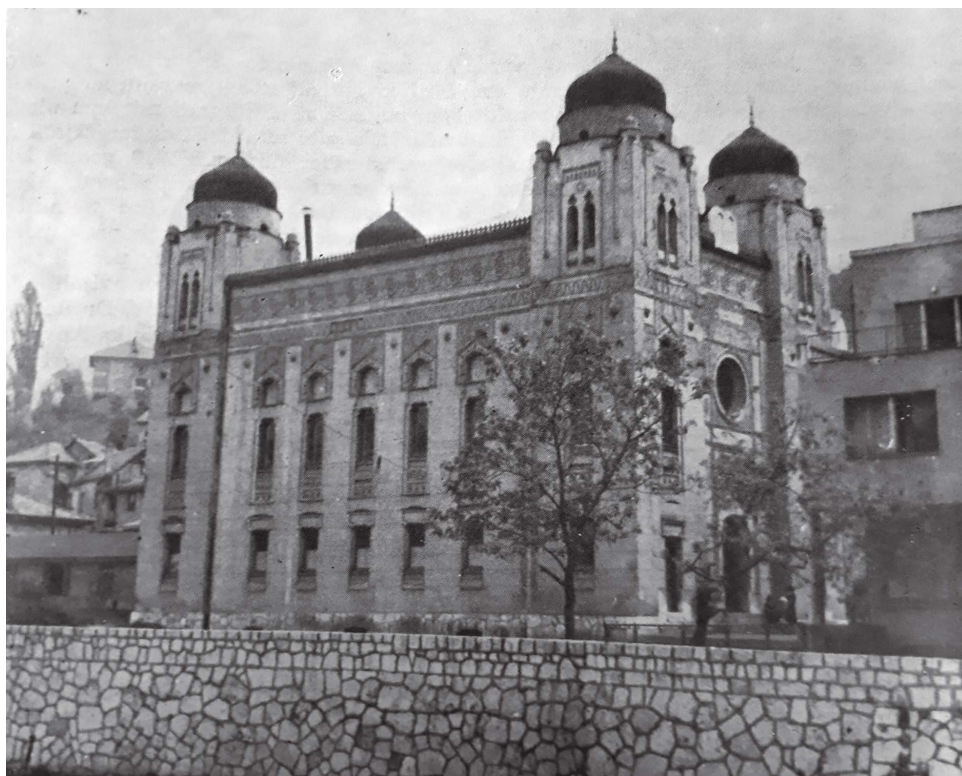
Slika 2. – Aškenaska sinagoga i zgrada Jevrejske opštine prije 1966. godine
