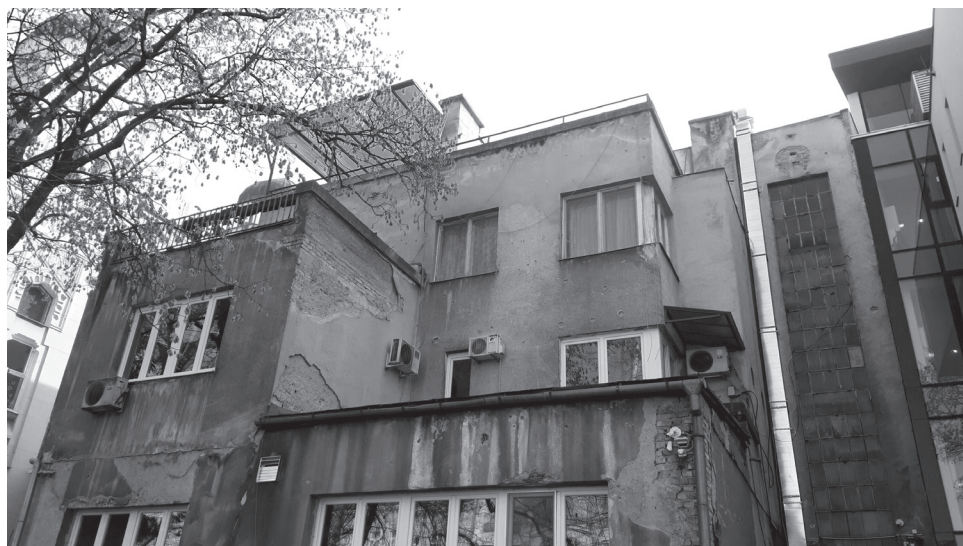
Slika 5. – Sjeverna fasada Jevrejske opštine Sarajevo, decembar, 2020.
