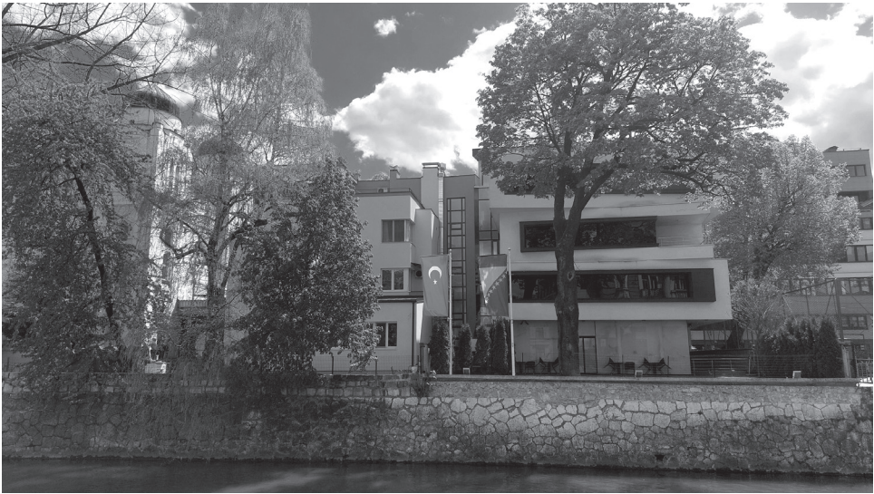
Slika 7. – Sjeverna fasada Jevrejske opštine Sarajevo nakon obnove, april, 2022.
