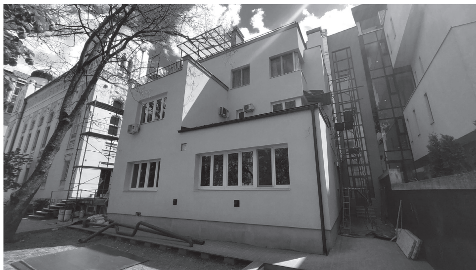
Slika 6. – Sjeverna fasada Jevrejske opštine Sarajevo nakon obnove, april, 2022.
